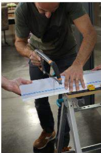
Kort de voorzijde van de rolluik-koffer in.
